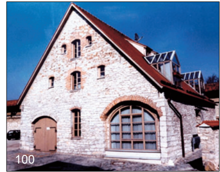
Denkmal mit Innendämmputz
