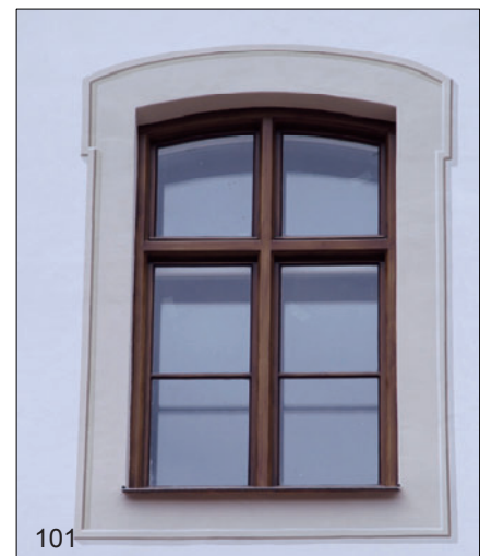
gut dämmendes Kastenfenster
